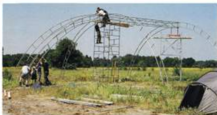
Wędrownicy z ZHR stawiają hangar
